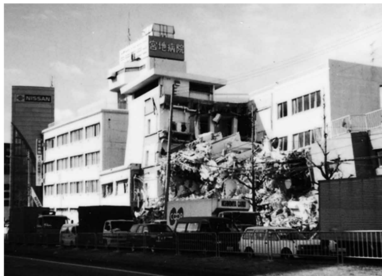
写真2 全壊した宮地病院（1階部分が崩壊し4階建てになった）
